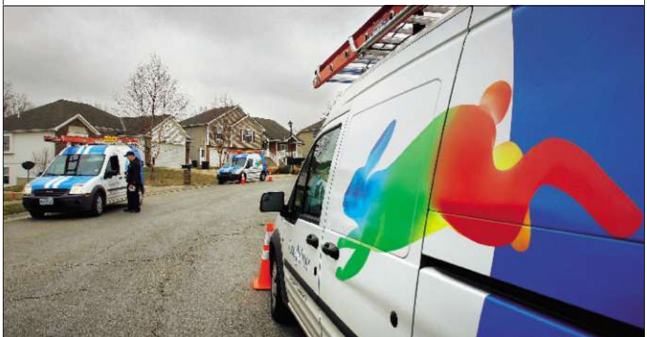
Flink wie ein Hase Google verlegt Glasfaserkabel in Kansas City
